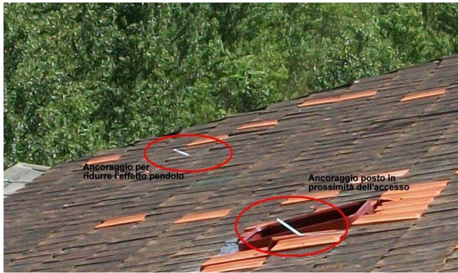
Lo schema seguente rappresenta una soluzione di principio di messa in sicurezza della copertura con l'uso di punti di ancoraggio:
