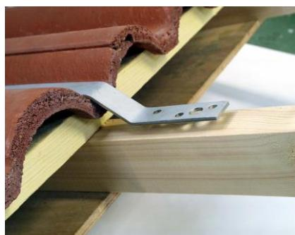
E' assolutamente da evitare di piegare l'ancoraggio in corrispondenza della foratura
