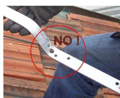
**NOTA BENE:** per l'installazione con chiodatura è necessario verificare le dimensioni del travetto (larghezza 50 mm e spessore 75 mm) ed usare esclusivamente chiodi originali DIMOS forniti con l'ancoraggio. Quest'ultimo, nella parte dello stelo destinata al fissaggio, deve appoggiare direttamente sul supporto a cui è inchiodato, senza interposizione di isolante o coibente.
