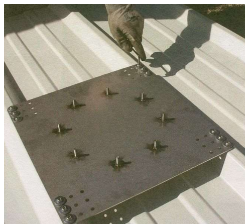
Fig. 10: fissaggio finale della piastra
