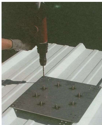
Fig. 7: preforatura
