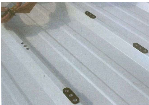
Fig. 9: incollaggio guarnizioni per inserti
