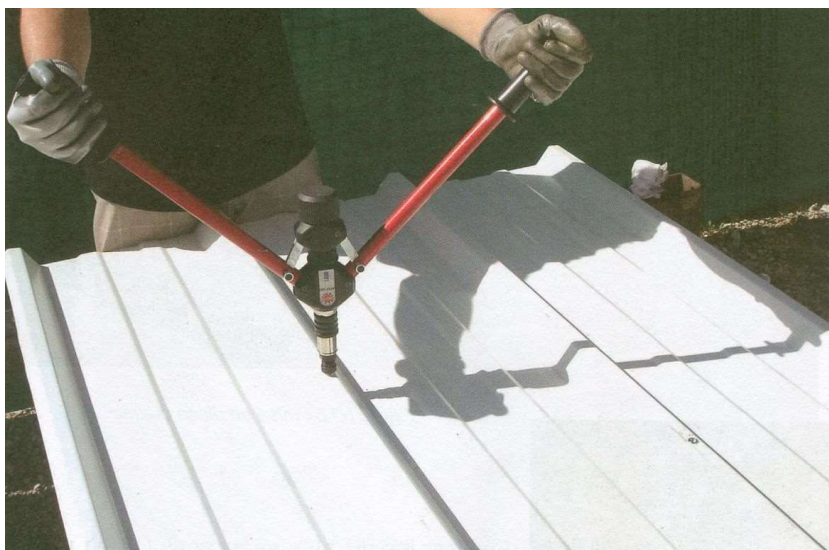
Figura 4: serraggio degli inserti
