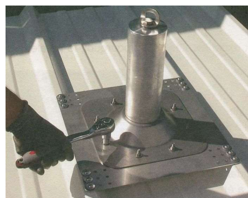
Fig. 14: serraggio dei dadi del paletto
