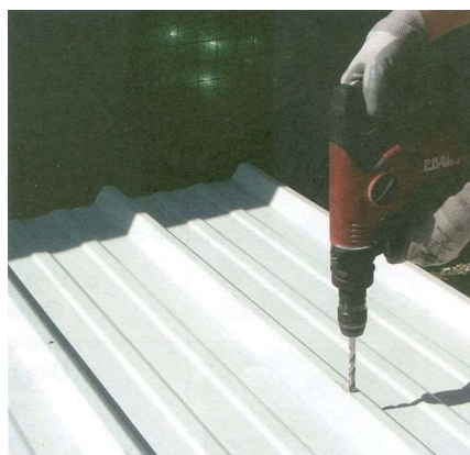
Figura 3: alesatura con foro da 9 mm
