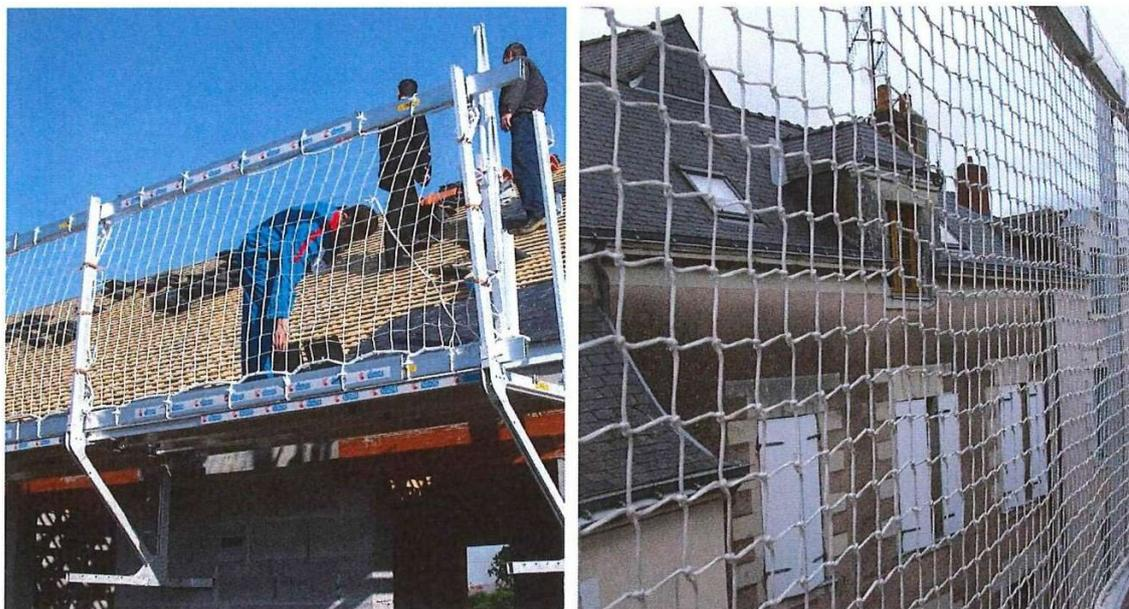
Da un punto di vista normativo (cfr EN 13374), le protezioni periferiche sono classificate in funzione della pendenza della copertura e della distanza di caduta (lunghezza della falda):
