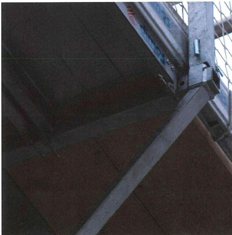
L'immagine mostra il dettaglio di messa in opera del dispositivo di sicurezza di blocco dell'impalcato.
