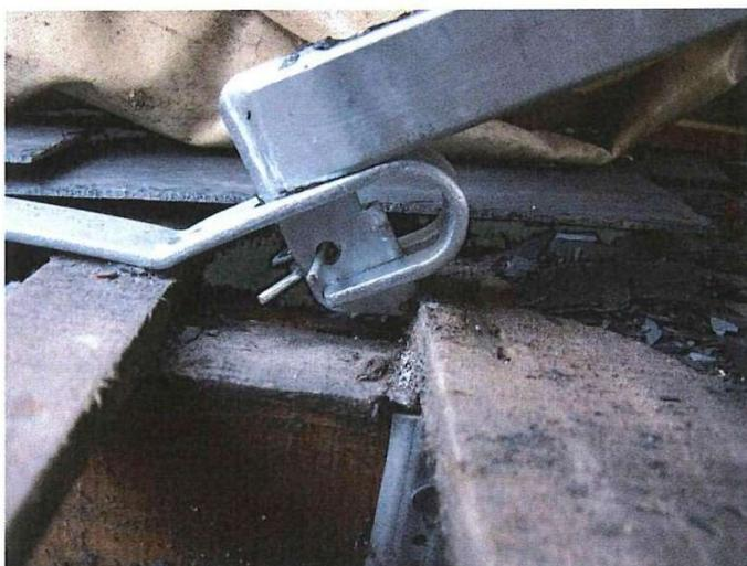
Esempio di posa di parapetto su ancoraggio permanente (si noti la coppia di sicurezza)
