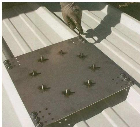
Fig. 10: fissaggio finale della piastra
