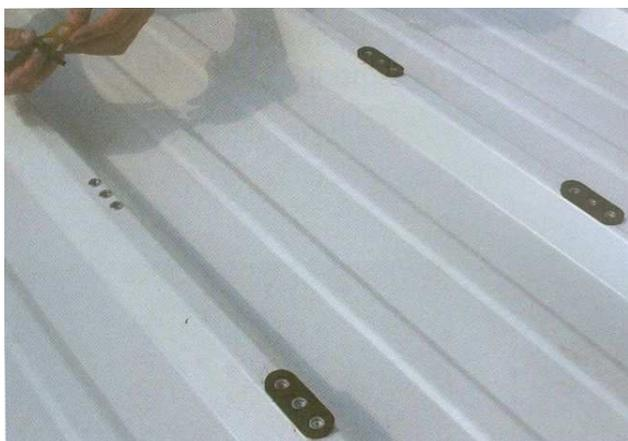
Fig. 9: incollaggio guarnizioni per inserti
