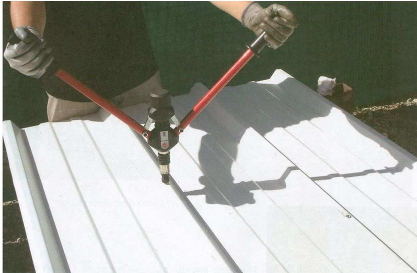
Figura 4: serraggio degli inserti
