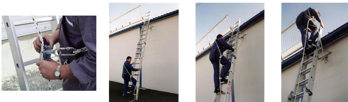
**NOTA BENE:** prima di sganciarsi dal DPI utilizzato lungo la scala è necessario assicurarsi ad un altro sistema anticaduta (punti di ancoraggio o fune anticaduta). A tale scopo è necessario utilizzare doppio cordino o sistema equivalente.
