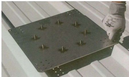
Fig. 6: posizionare la piastra
