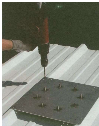
Fig. 7: preforatura
