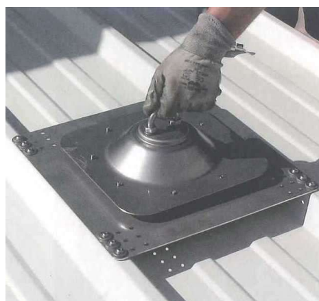
Fig. 13: posa in opera dell'ancoraggio
