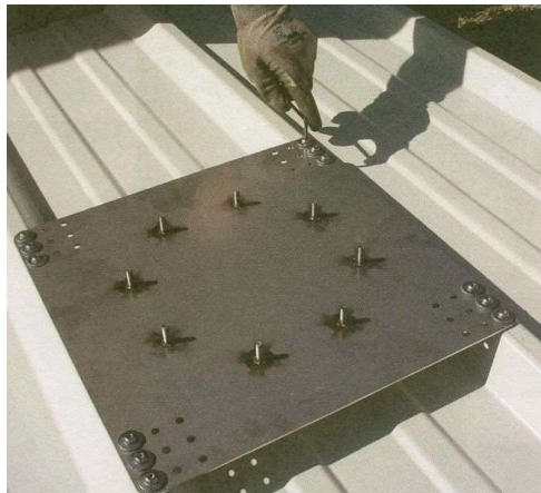
Fig. 10: fissaggio finale della piastra
