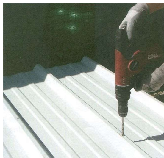
Figura 3: alesatura con foro da 9 mm
