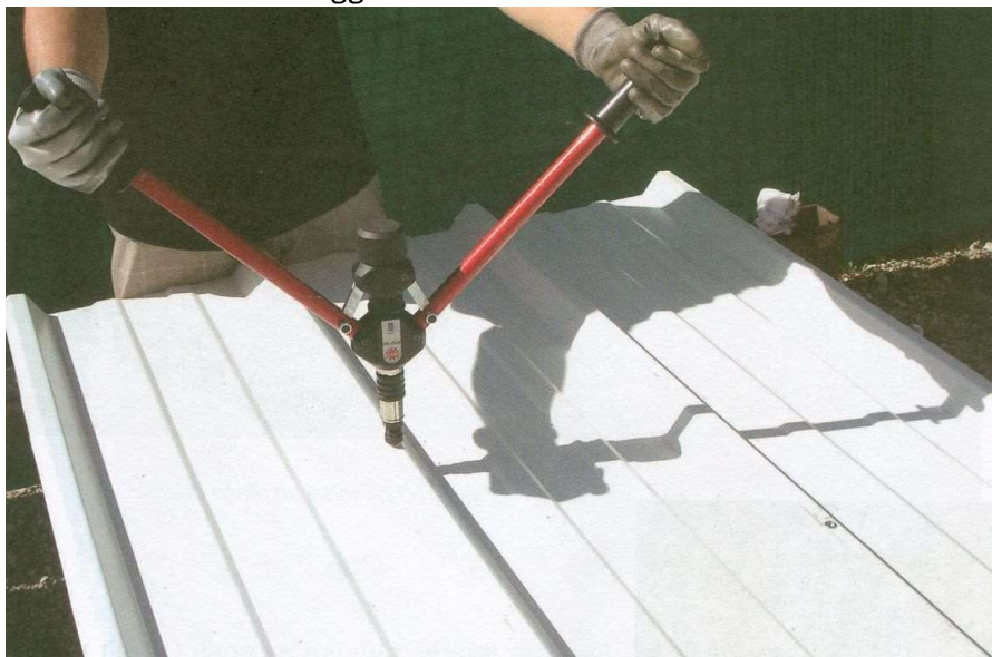
Figura 4: serraggio degli inserti
