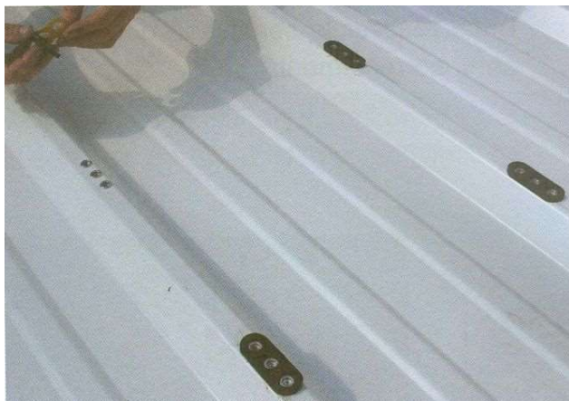
Fig. 9: incollaggio guarnizioni per inserti
